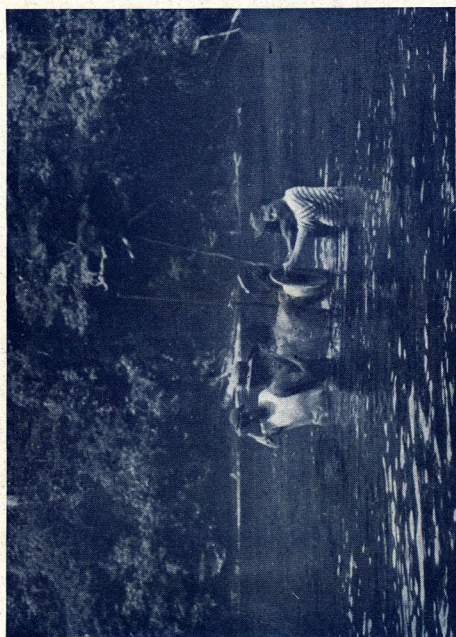
SONDAGE MÉTHODIQUE DES ALLUVIONS SOUS L'EAU : CHERCHANT LA PLACE POUR ENFONCER LA SONDE.
