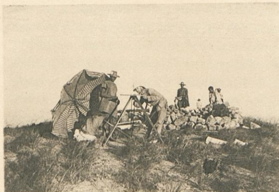
Construction d'un signal géodésique.
